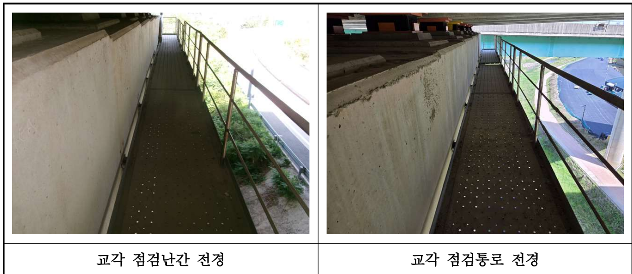
【사진 39.3.26】 교량 점검시설 전경
