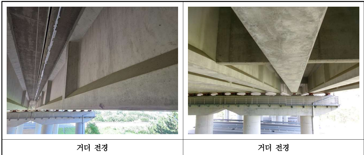
【사진 39.3.4】 거더 전경
