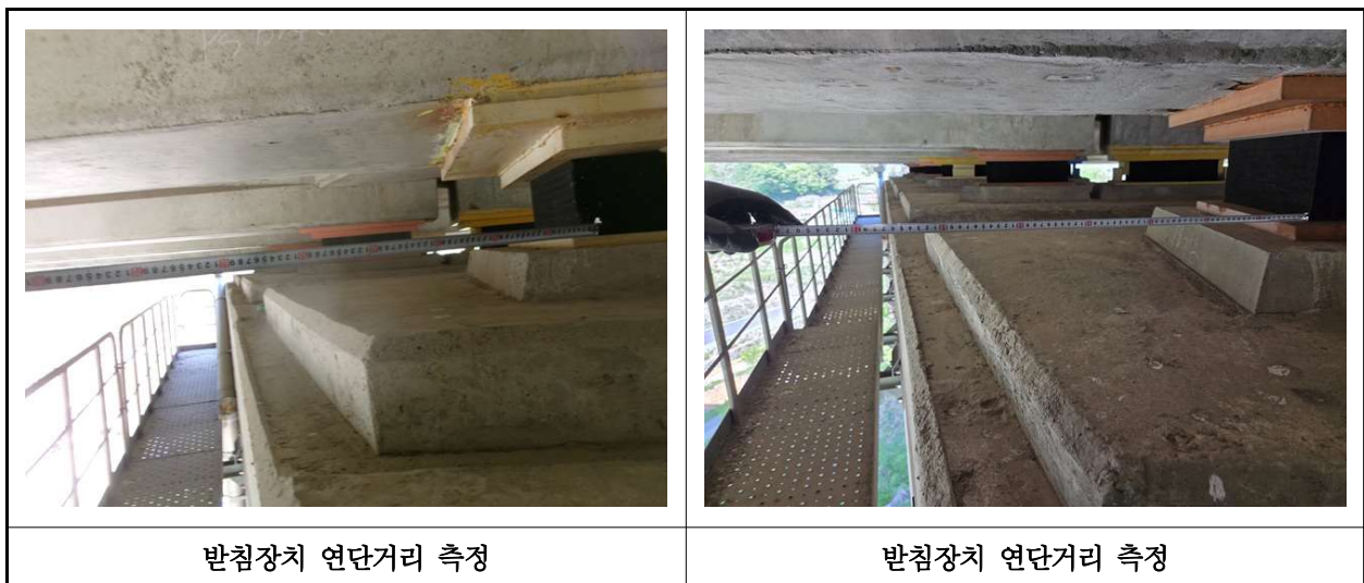
【사진 39.3.15】 교량받침장치 연단거리측정
