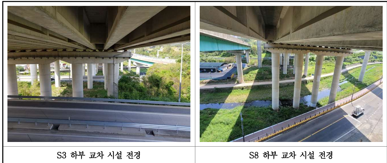
【사진 39.2.1】 주변환경 및 하중변화 전경(계속)
