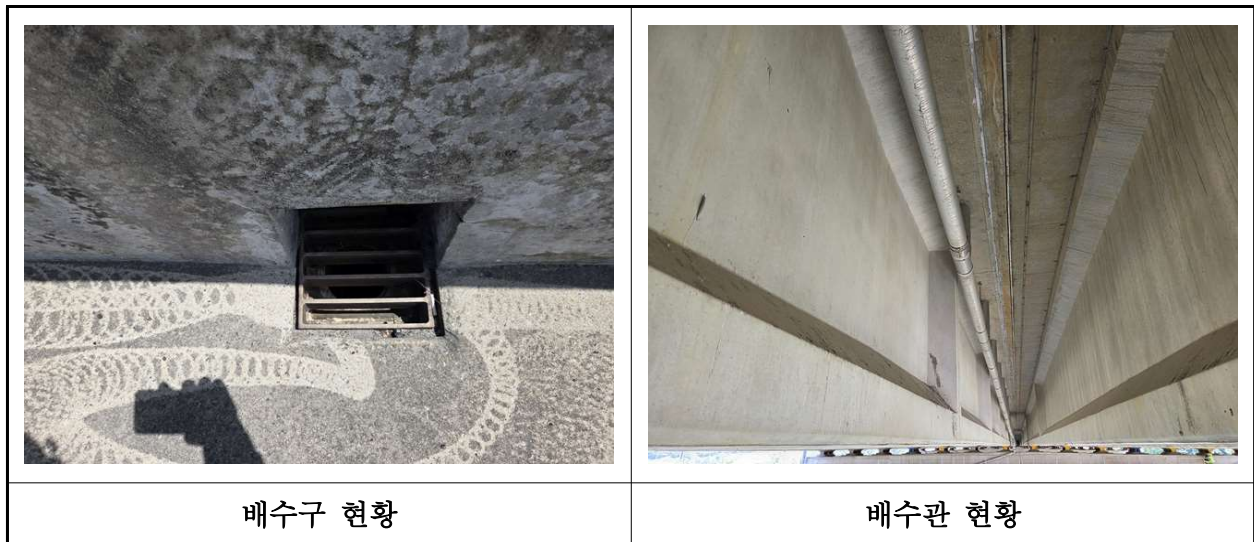
【사진 39.3.22】 배수시설 전경
