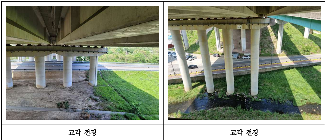
【사진 39.3.10】 교각 전경
