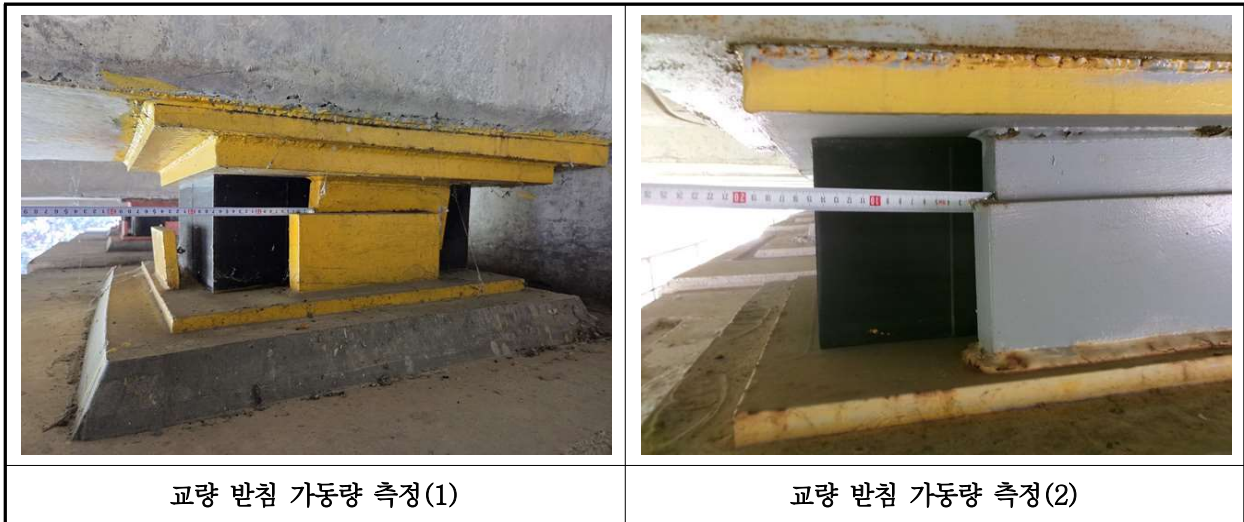
【사진 39.3.16】 교량받침 이동량 측정
