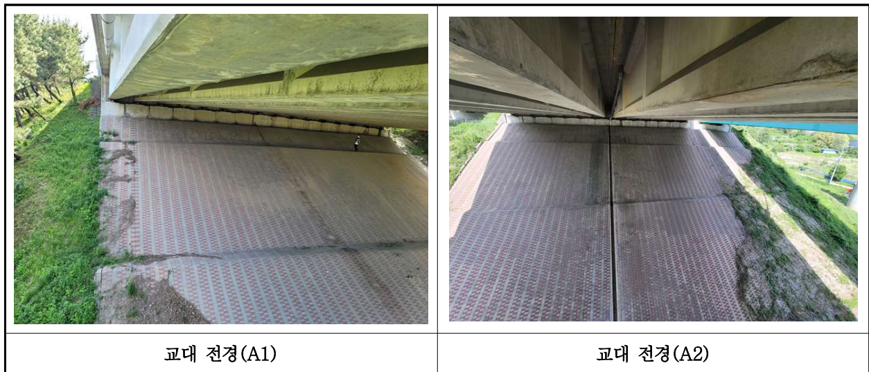
【사진 39.3.8】 교대 전경
