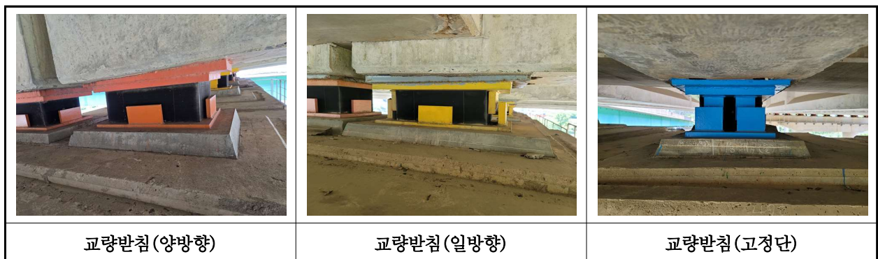
【사진 39.3.13】 교량받침 전경
