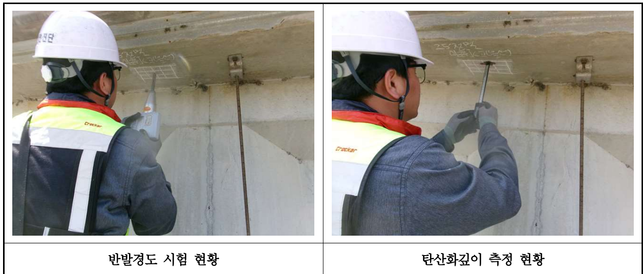
【사진 39.4.1】 콘크리트 내구성조사 현황
